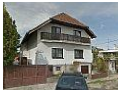
Kolaudácia - nadstavba na 2-byt. jednotky
